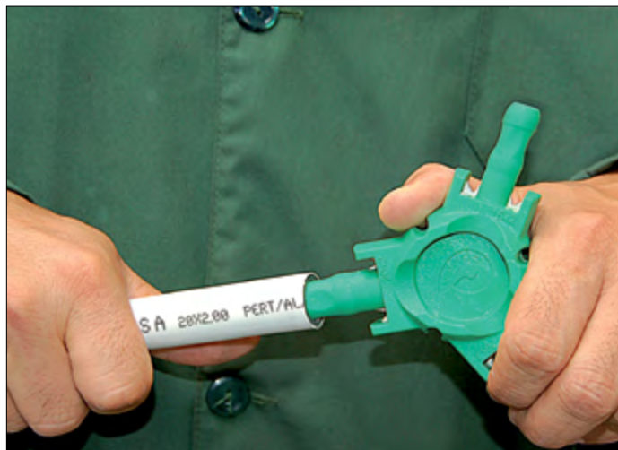
2. Провести калибровку трубы подходящим калибратором
